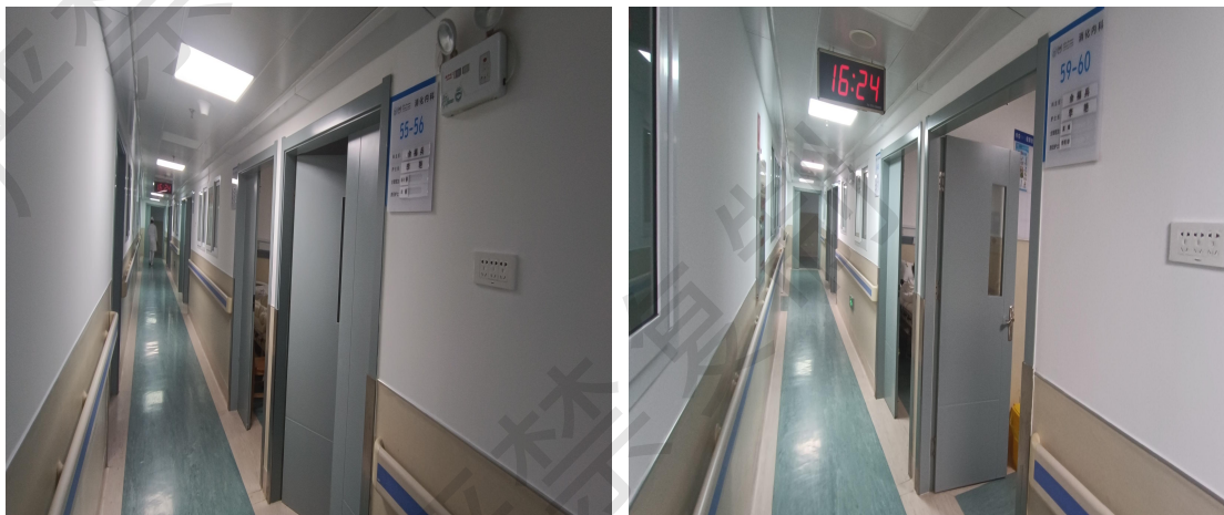
拟建 DSA 机房楼上四楼现状
